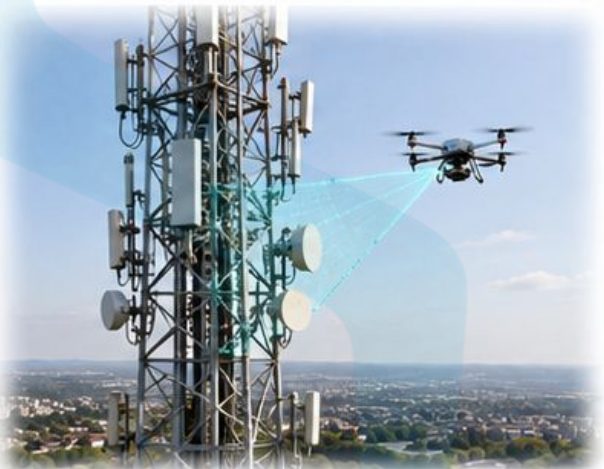
— Torres de telecomunicaciones
